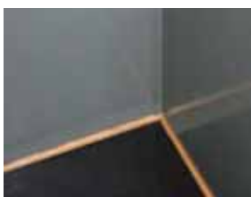
Holz Sockelleiste aus wasserdichten Hartholz
