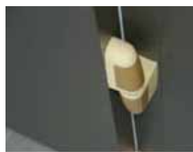
Isolierte Tür mit stumpf-steigenden Bändern
